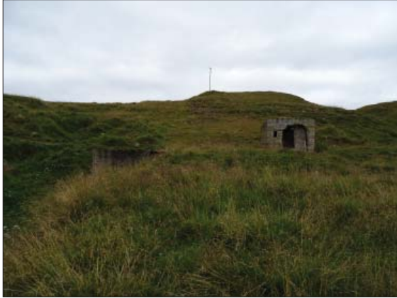
Rafstöðvar SK-117:013_1 og 2, horft til suðvesturs.
