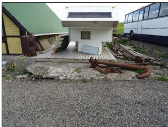
Grunnur EY-288:006_2, horft til SSA.
